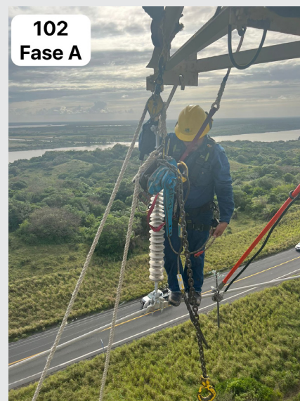
Figura 3 Cambio de Aisladores tipo sintético. Fuente: Elaboración propia.
