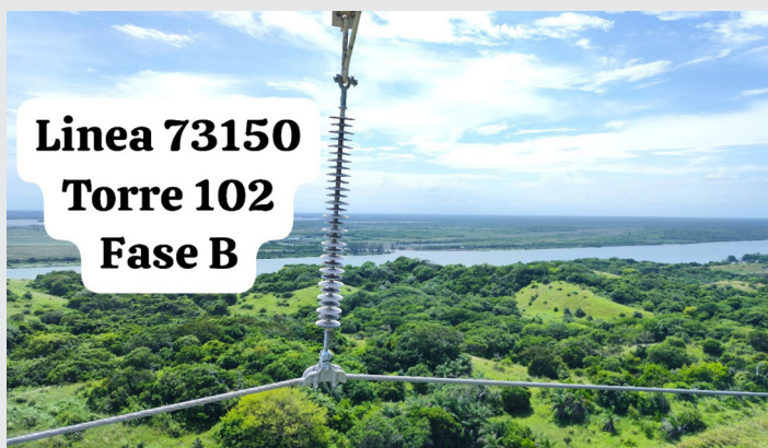
Figura 5 Perspectiva de los Herrajes y aislador. Fuente: Elaboración propia.
