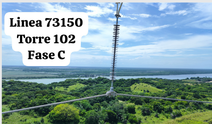
Figura 4 Perspectiva del Aislador. Fuente: Elaboración propia.
